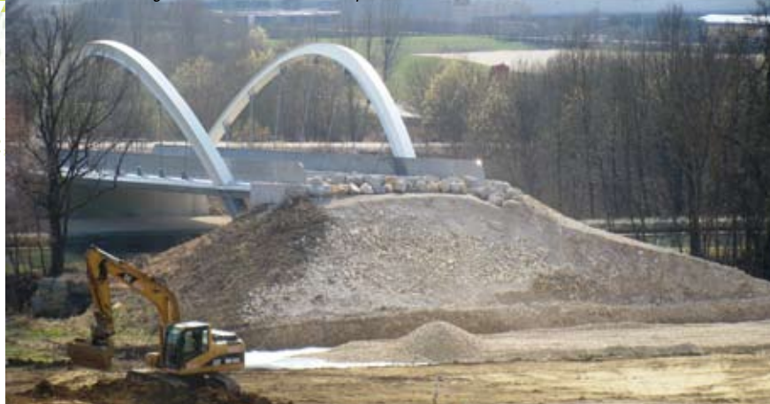
Travaux d'aménagement de l'accès sud via le pont Technoland - mars 2010
